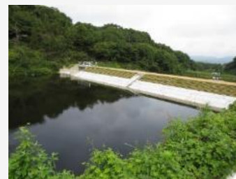
整備後のため池
