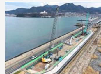
堤防の耐震化(岡山県岡山市)
