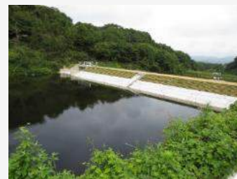
整備後のため池
