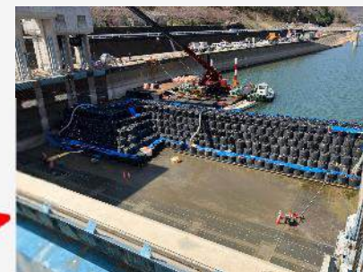
【堰の改修作業】
