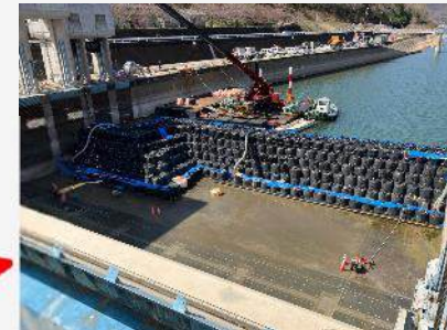
【堰の改修作業】
