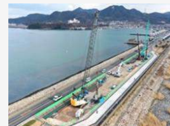
堤防の耐震化(岡山県岡山市)
