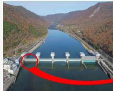
【堰を上空からみた全体像】
