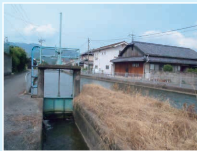
▲幹線用水路 手動の分水ゲートを自動化に更新
