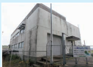
▲邑久牛窓揚水機場
