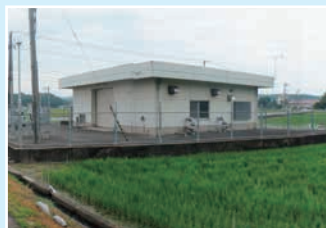
▲太伯朝日揚水機場
