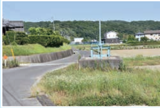
▲邑久用水路(サイホン・トンネル)
