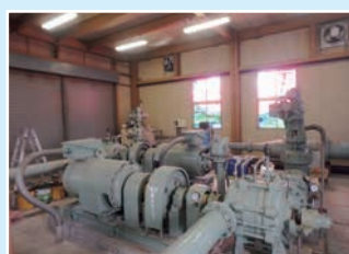
▲浮田玉井揚水機場
