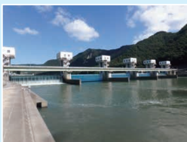
▲右岸下流側から撮影
