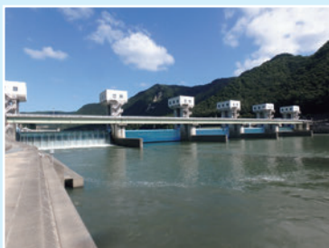
▲右岸下流側から撮影
