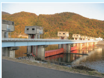
▲右岸下流側から撮影
