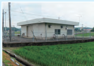
▲太伯朝日揚水機場
