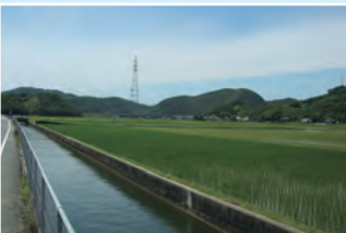
▲樋ノ口用水路
