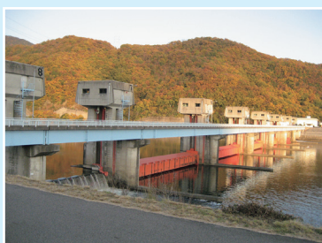
▲右岸下流側から撮影
