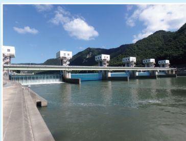
▲右岸下流側から撮影
