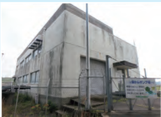
▲邑久牛窓揚水機場
