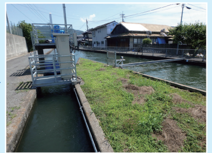
▲幹線用水路 手動の分水ゲートを自動化に更新
