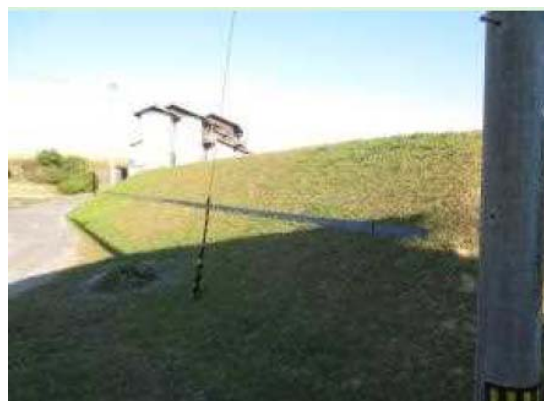
畦畔の法面に小段設置
