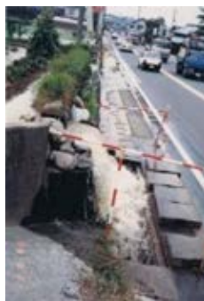
道後南部幹線水路(表川サイホン) RC管継ぎ目から漏水し国道11号線へ流出(撮影S63)
