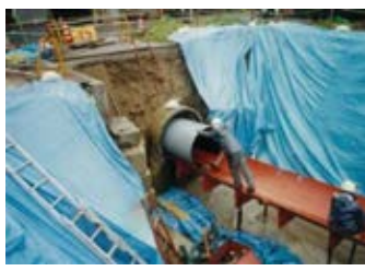
新工法(巻き込み鋼管)による改修
