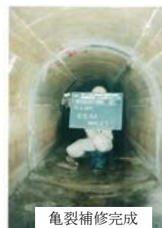
新工法(巻き込み鋼管)による改修
