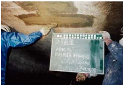
暗渠水路の上部のひび割れをポリマーセメントモルタルで補修している写真
