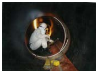
新工法(巻き込み鋼管)による改修
