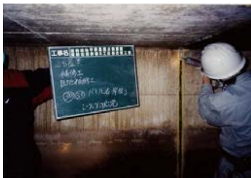
水路の目地の開き部をシーリング材で充填している写真
