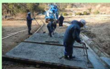
直営施工による農道舗装
