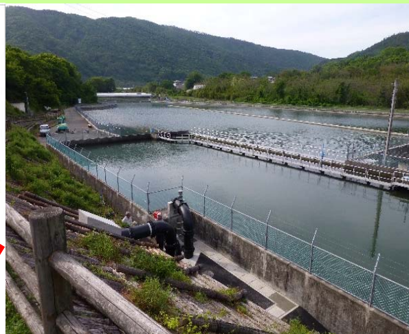
間伐材を利用した法面保護工
