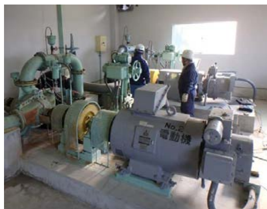
写真 [ポンプの調査状況]
