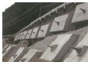
地すべり対策（アンカー工）
