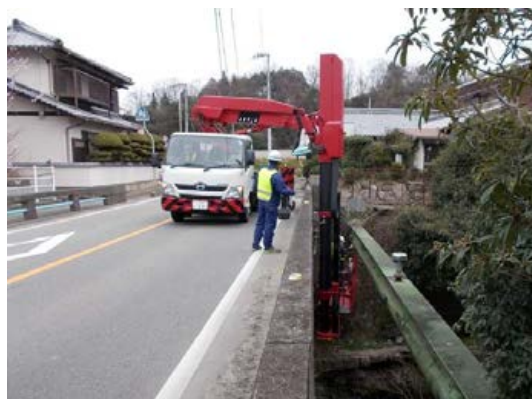
写真 [水管橋の調査状況]
