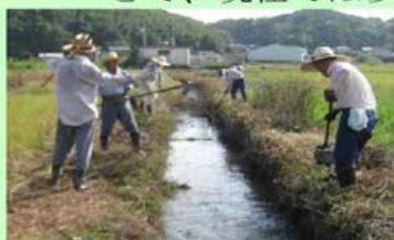
水路の泥上げ作業
