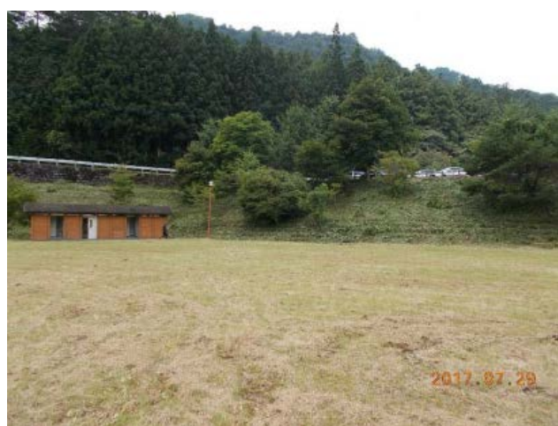
作業終了後の風景
