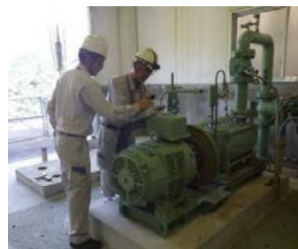
ポンプ設備調査
