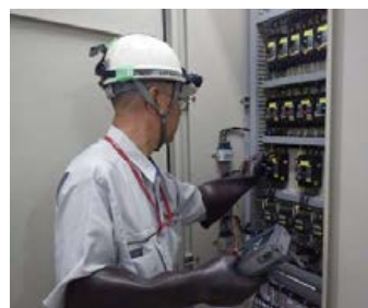
電気設備調査
