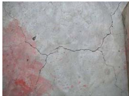
野村ダム取水塔
