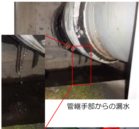
野村ダム取水塔の継手部からの漏水
