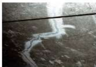
補修後（ひび割れ注入工例）
