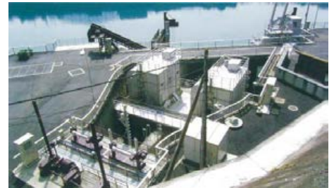
吉野川北岸用水取水工
