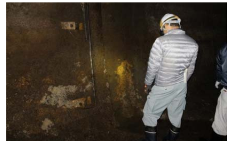
池田トンネルの内部
