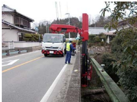
写真 [水管橋の調査状況]
