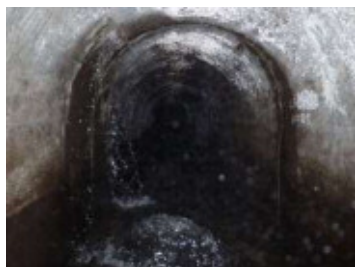
隧道内のひび割れからの漏水状況
