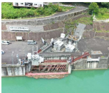
「池田取水工」（現況）
