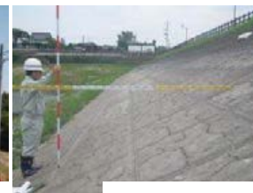
堤体の断面測量
