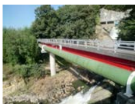
水管橋の橋脚の補強等を行い耐震性を向上
