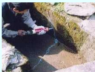
水路のひび割れ補修
