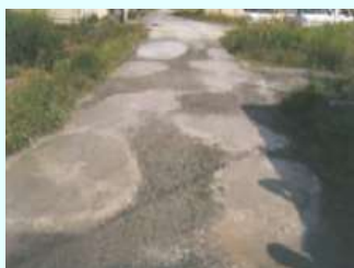
農道の窪みの補修
