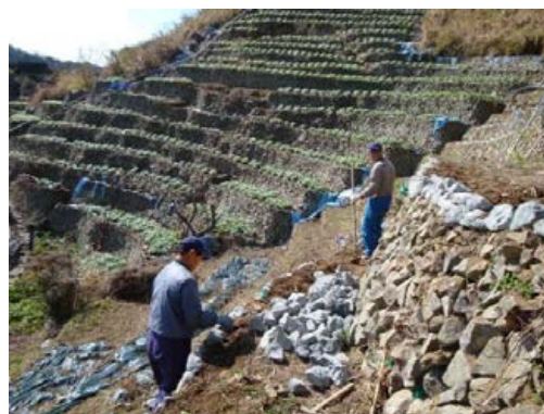
石垣の修復の様子
