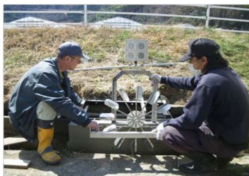
小型水力発電機の設置
