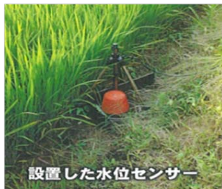
自動給水施設の設置
