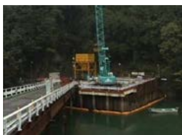
バイパストンネル掘削立坑
