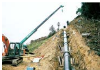
開削工法によるサイホンの改修
