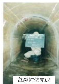
新工法（巻き込み鋼管）による改修
