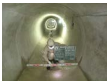
道後導水路工事 完成
