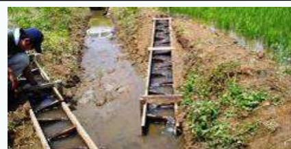
水田魚道の設置
