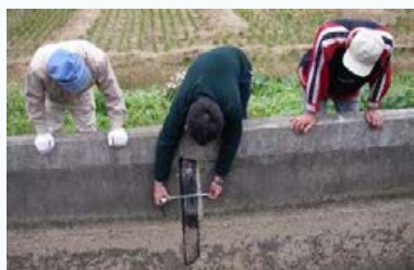
施設の機能診断
