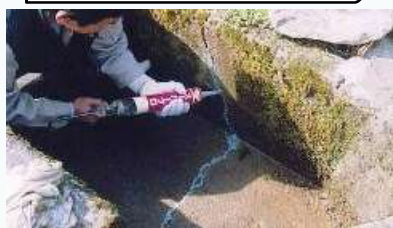
水路のひび割れ補修
