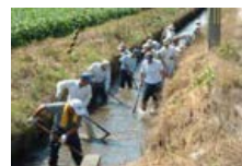
水路の泥上げ
