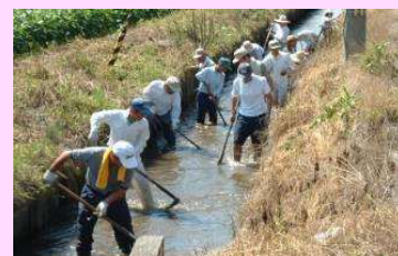
水路の泥上げ
