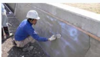
老朽化した水路壁のコーティング
