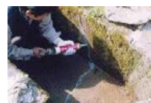
水路のひび割れ補修
