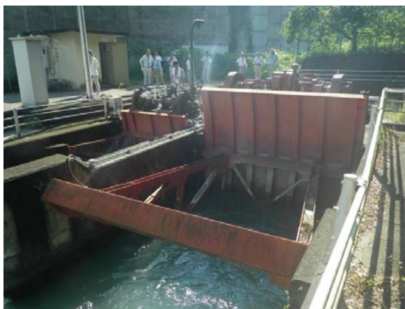
写真1【現地調査状況】
