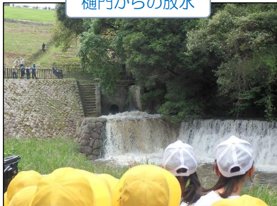
樋門からの放水
