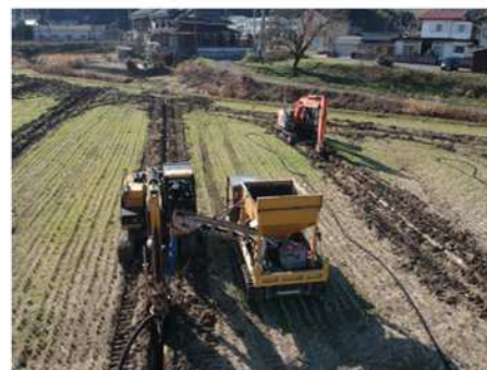
暗渠排水工事の実施状況
