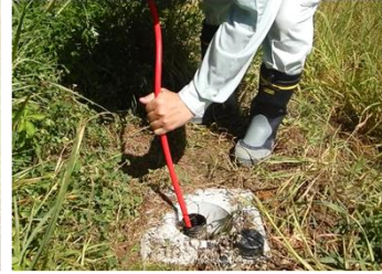
支線パイプ洗浄
