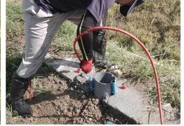
接続パイプ洗浄
