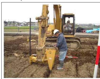
アーム補助孔施工機による補助孔の施工
