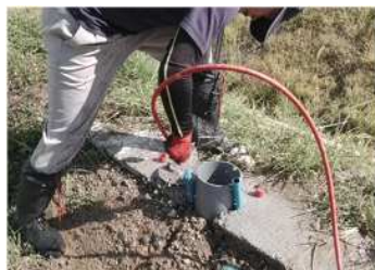
接続パイプ洗浄
