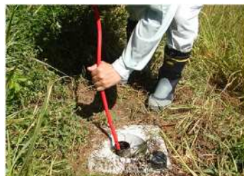
支線パイプ洗浄
