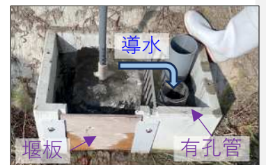
イ 有孔管と堰板の設置、ウ 導水
