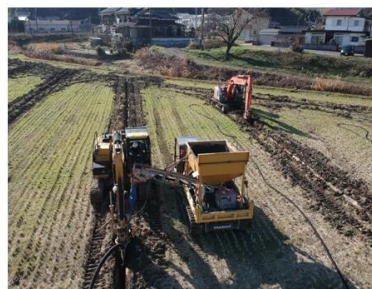
暗渠排水工事の実施状況
