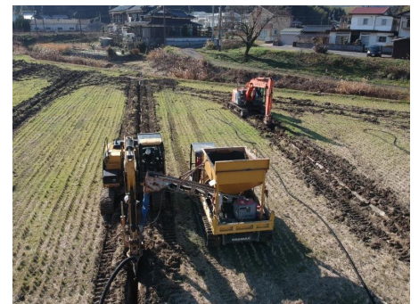
暗渠排水工事の実施状況
