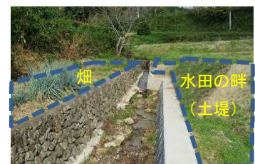
ホタル水路両側の土堤
