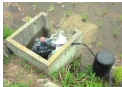
パイプライン化による自動給水栓
