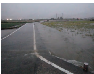
既設水路溢水 (田野上方東団地)
