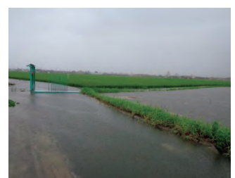
既設水路溢水 (北条団地)
