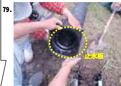
④ソケットに止水板の取付け
