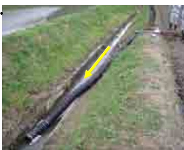
⑧魚道全景(下流側から)
