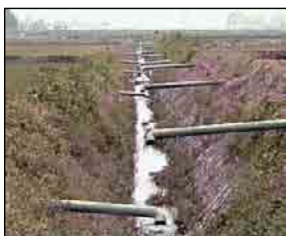
ほ場整備後の田んぼと排水路の落差
