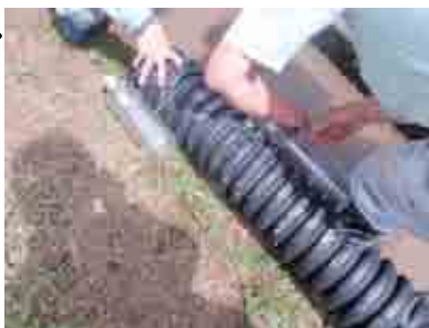
⑦魚道入口への浮きの設置
