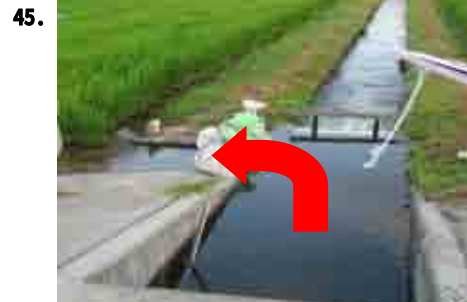
堰上げ取水管理
