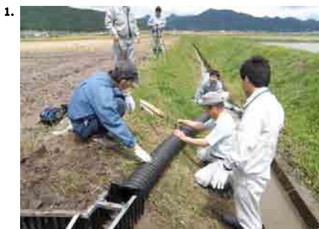
水田魚道の設置
