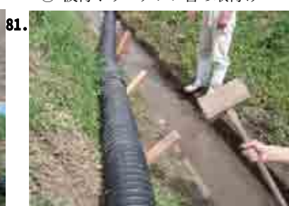
⑥杭での固定
