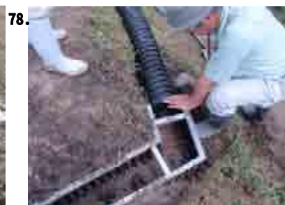
③波付ポリエチレン管の取付け
