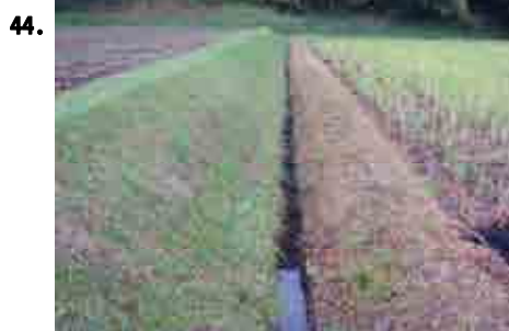
承水路（非かんがい期）
