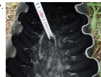
通水試験(水深の測定)
