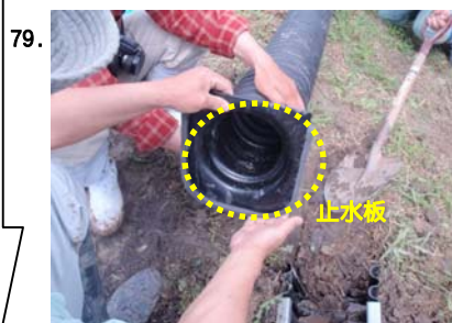
ソケットに止水板の取付け
