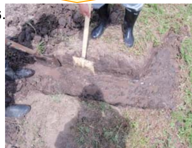
畦畔掘削完了
