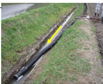
魚道全景(下流側から)
