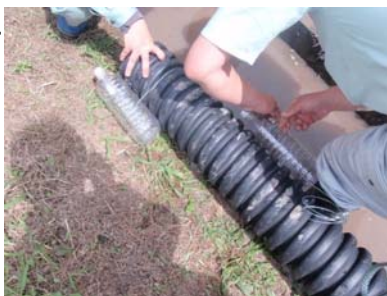
魚道入口への浮きの設置
