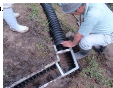
波付ポリエチレン管の取付け
