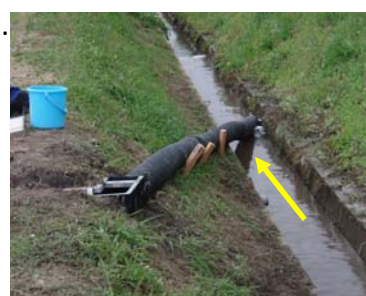
魚道全景(上流側から)
