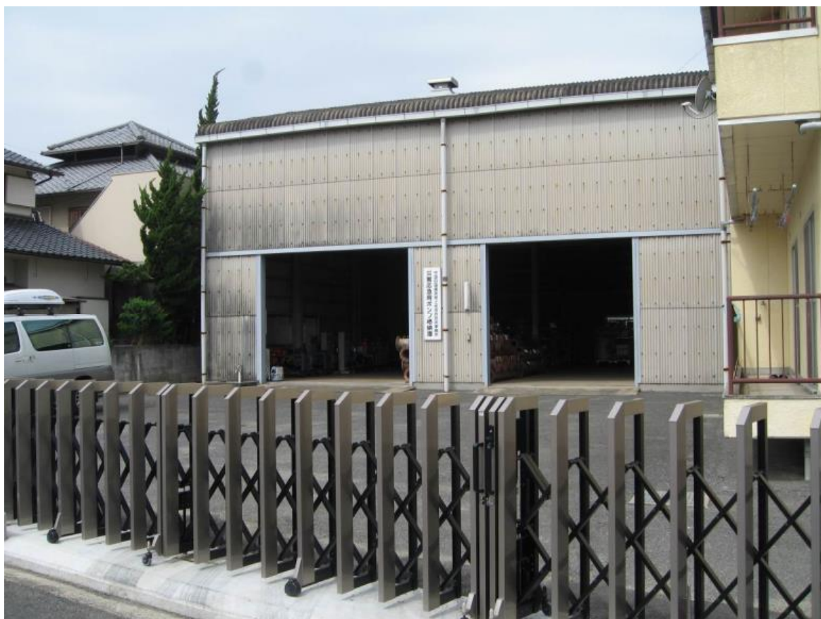
中国四国農政局土地改良技術事務所 大和町庁舎（ポンプ格納庫）
