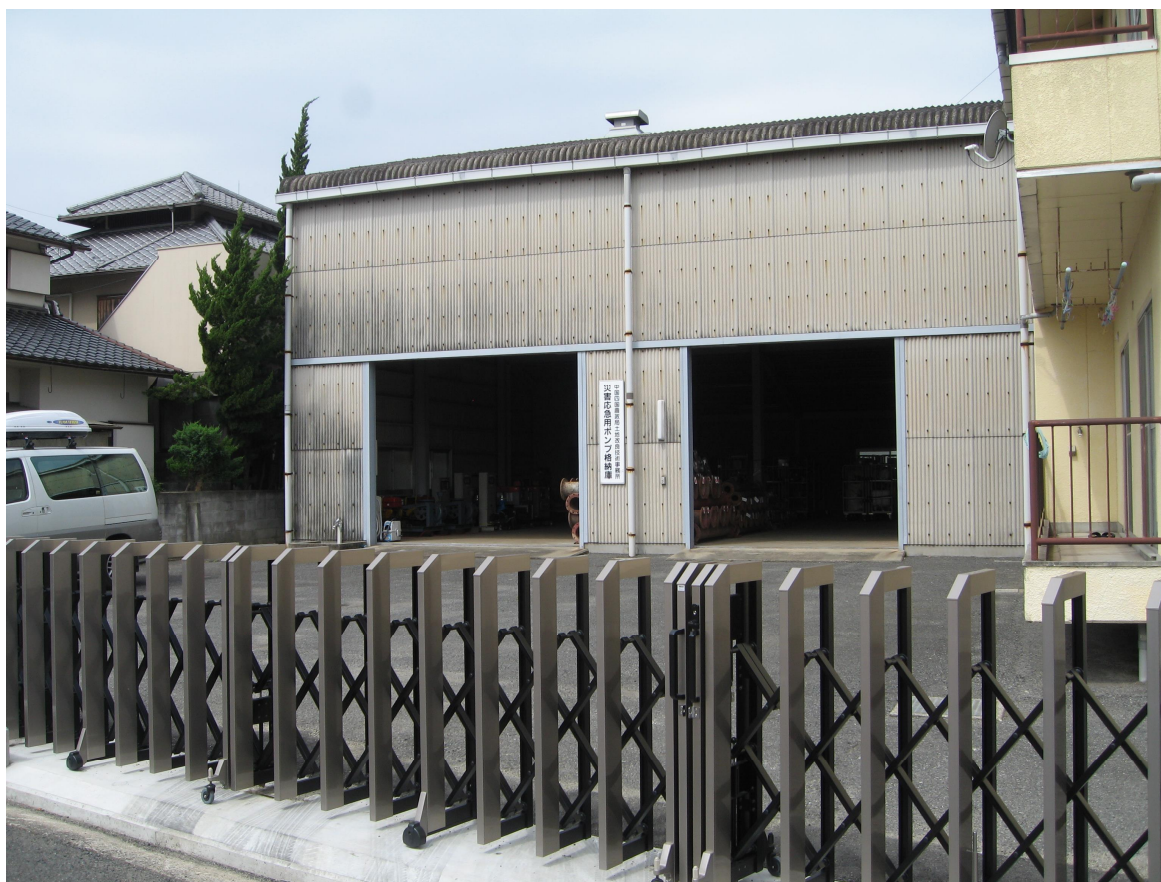
中国四国農政局土地改良技術事務所 大和町庁舎（ポンプ格納庫）
