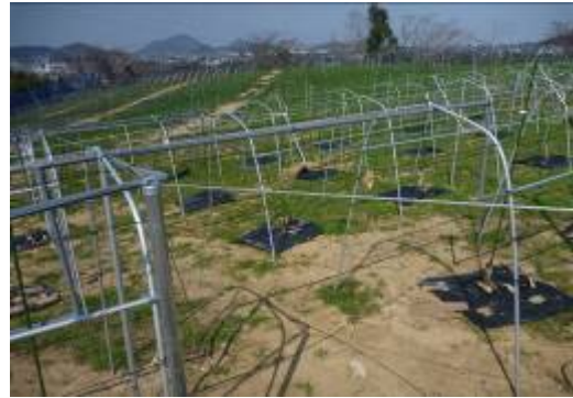
再生・施設整備後の園地
