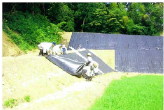
防草シート設置による畦畔雑草対策
