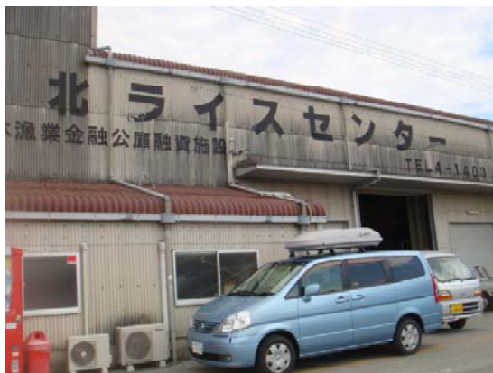
事務所（左下）及び米乾燥機16台 を収納するライスセンター（全体）
