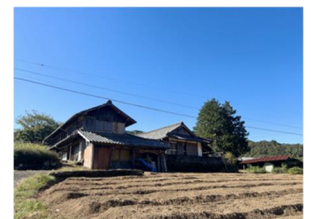
古民家改装中
