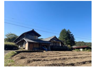
古民家改装中
