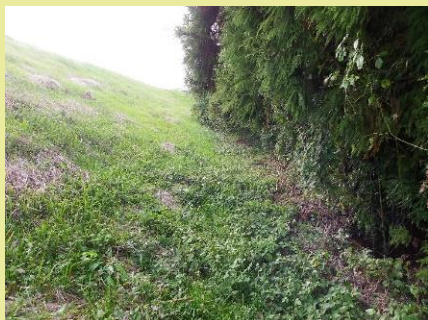
山に接した堤体
