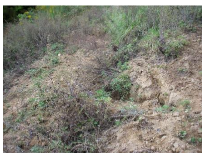
ため池法面の掘り跡
