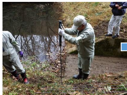
支柱の打ち込み
