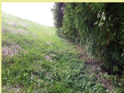
山に接した堤体
