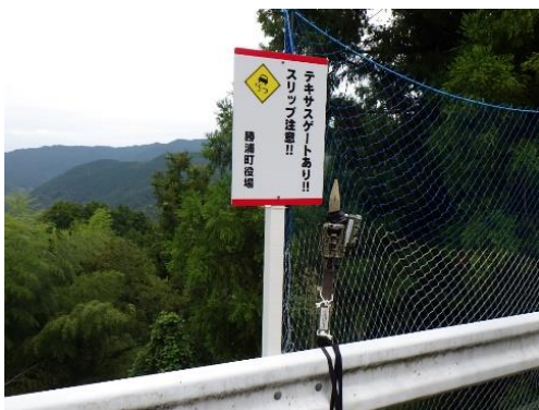
グレーチングの存在を周知する看板
